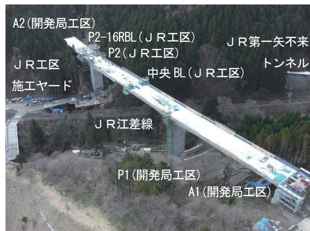
写真－7 館野高架橋全景
