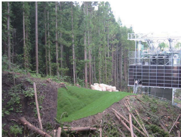
写真-2 移動作業車干渉部施工状況
