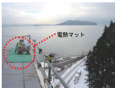
写真－5 つらら対策実施状況
