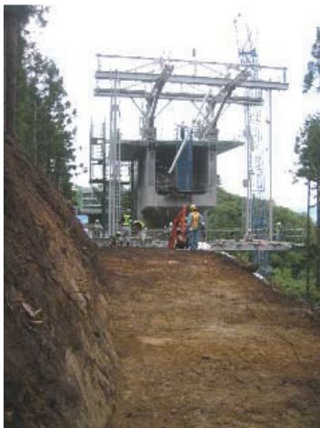
写真-1 干渉部切取状況
