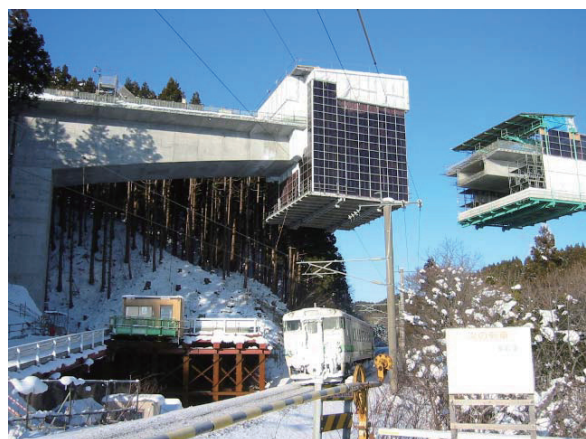
写真-3 中央径間施工状況
