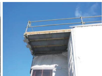
写真－6 つらら対策実施後
