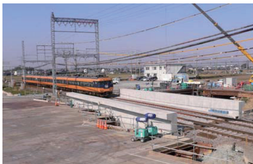
写真-4 架設完了後の富屋川橋梁
