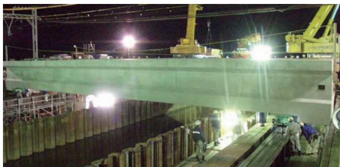
写真-3 横取り中の富屋川橋梁
