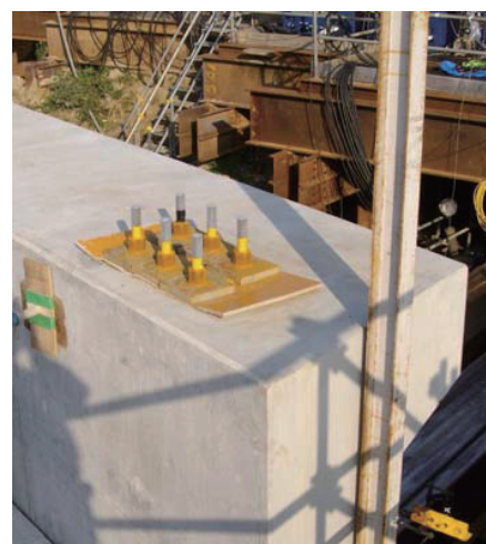
写真-1 補強PC鋼棒
