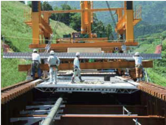
写真－5 架設状況
