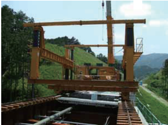
写真-3 PC床版架設機
