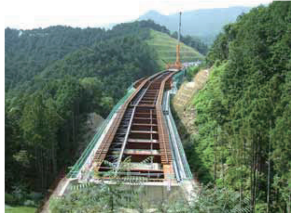
写真-4 床版架設機軌条
