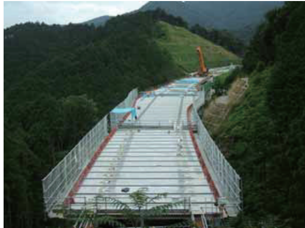
写真－6 架設完了
