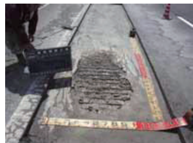
写真-1 床版上面の粒状化
