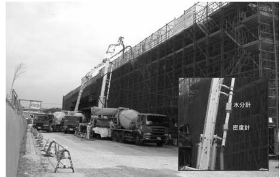
図-13 連続R I法測定状況
