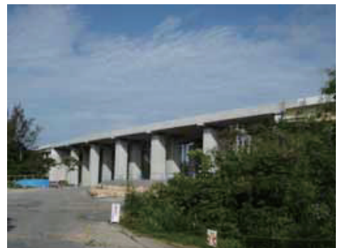
写真－5 完成状況（上り線）
