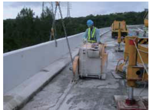
写真－2 張出し床版撤去状況
