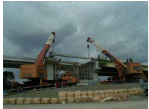
写真－3 主桁の架設状況
