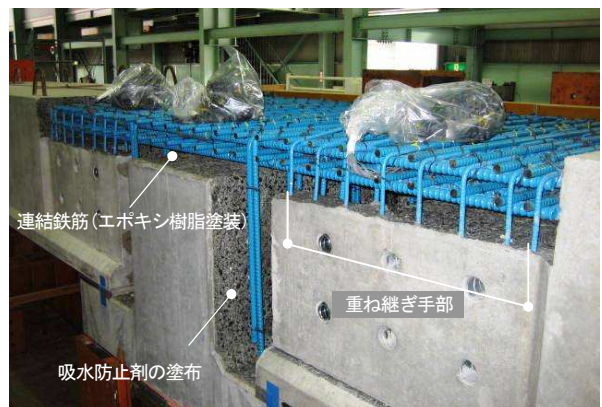
写真-2 連結鉄筋配置
