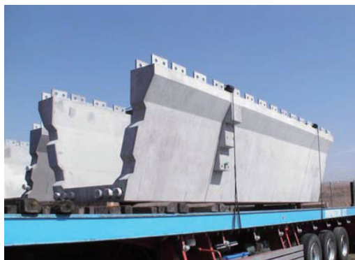
写真-1 UFCプレキャスト桁
