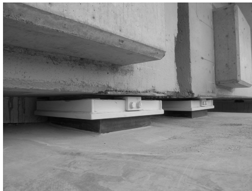
写真-4 支承取替後
