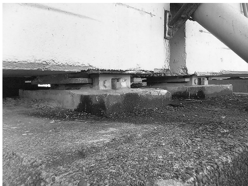
写真-3 支承取替前
