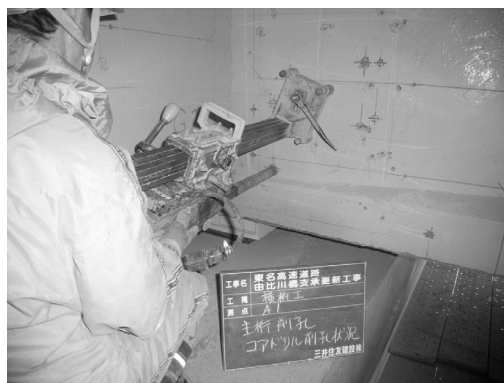
写真-5 コア削孔状況
