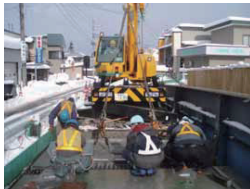
写真-4 新設床版設置状況
