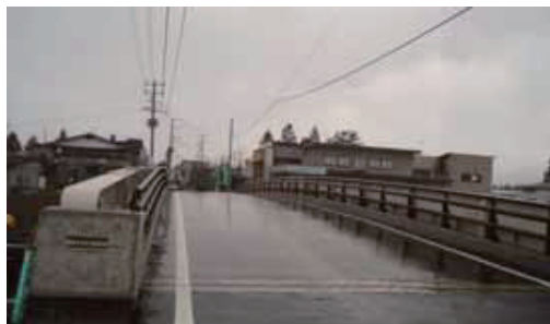
写真-1 完成状況
