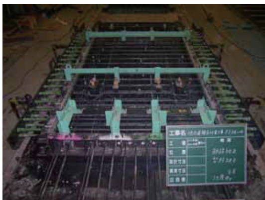
写真-2 組立て完了
