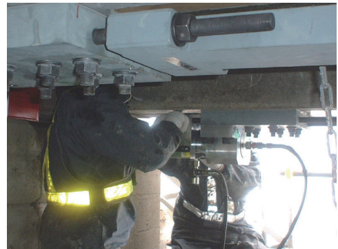
写真—3 緊張作業
