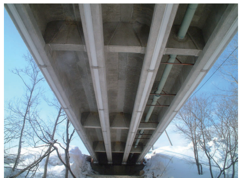
写真—4 施工完了後状況
