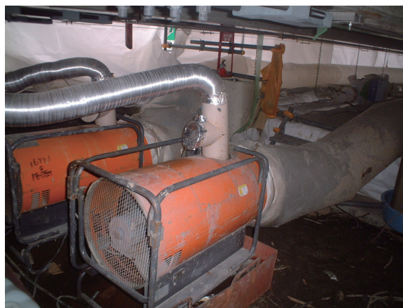
写真—1 養生状況
