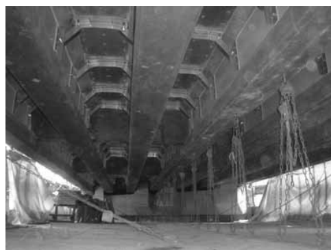
写真-2 床版間詰部鋼板補強 (T桁橋)
