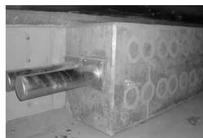
写真-5 定着突起 (箱桁内部)
