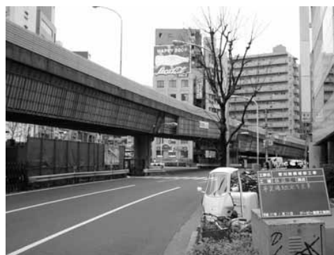
写真-1 菅刈陸橋
