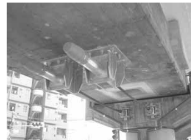
写真-7 落橋防止連結ケーブル
