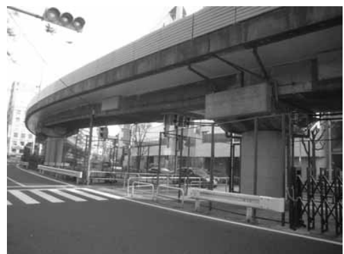
写真-8 補修後の全景
