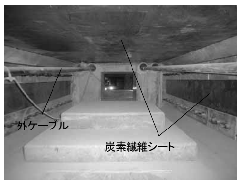
写真-3 箱桁内部 (PC3径間連続箱桁橋)
