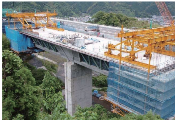
写真-1 張出し架設中(平成20年6月)
