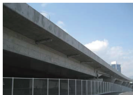
写真-1 完成写真
