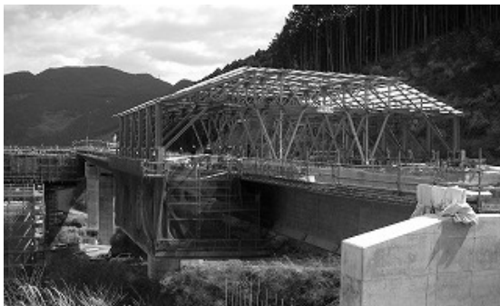
写真-1 拡幅施工用移動作業車
