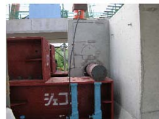
吊上げ部の耐力確認試験
