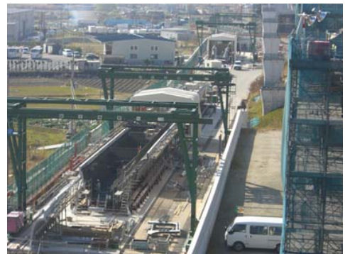
写真-1 U桁製作ヤード全景
