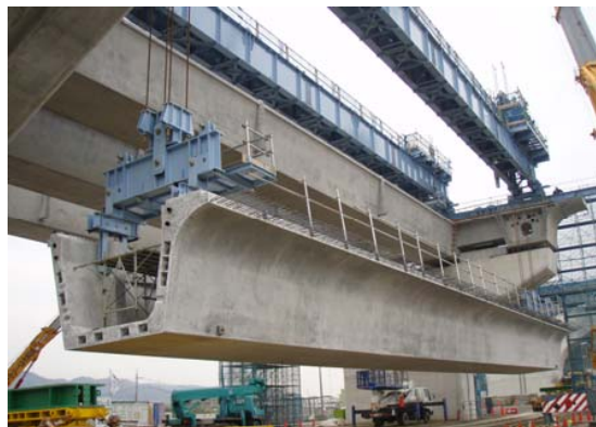
写真-3 U桁吊上げ状況
