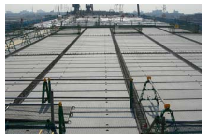
写真-6 上床版施工状況(PC板敷設)
