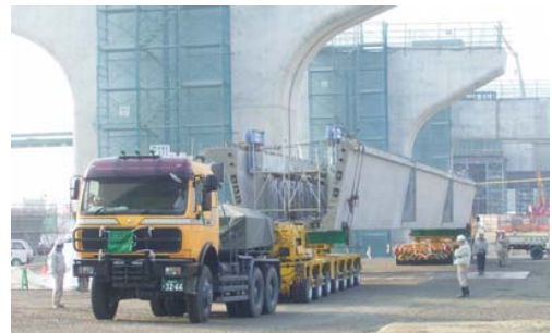
写真-2 U桁の場内運搬状況
