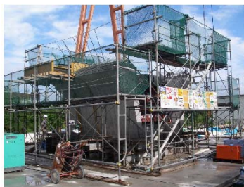
実橋同一断面の桁を製作
