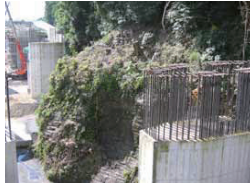
写真－2 崖部の迫り出し（施工前）
