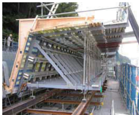
写真－5 送り出し型枠
