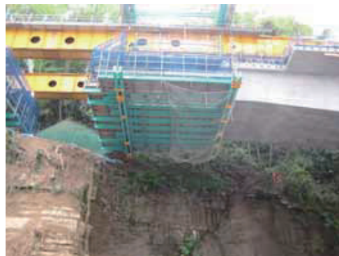
写真－4 コア断面での張出し架設
