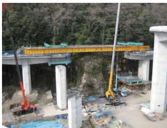
写真-1 架設状況
