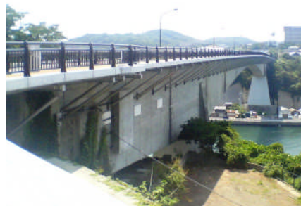
写真-5 完成状況
