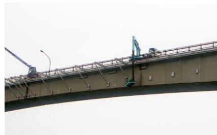
写真-3 トラスの架設状況
