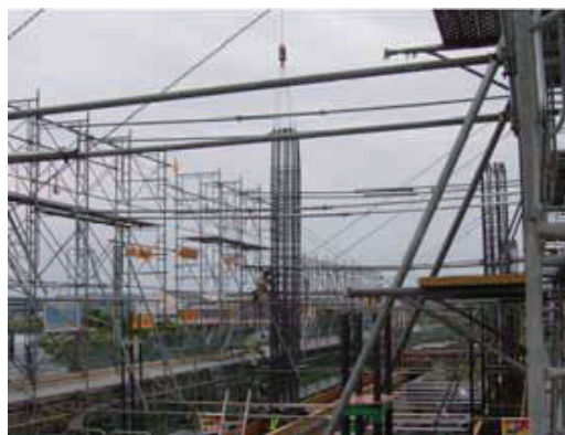
写真－1 鉛直材鉄筋建込み状況
