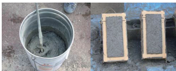
写真-4 導電性モルタル施工
