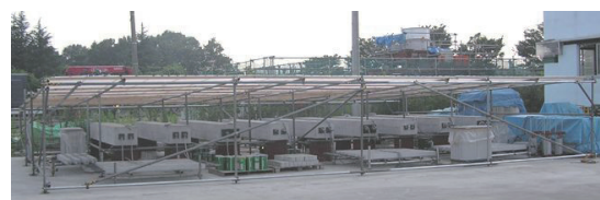
写真-2 暴露状況 2)
