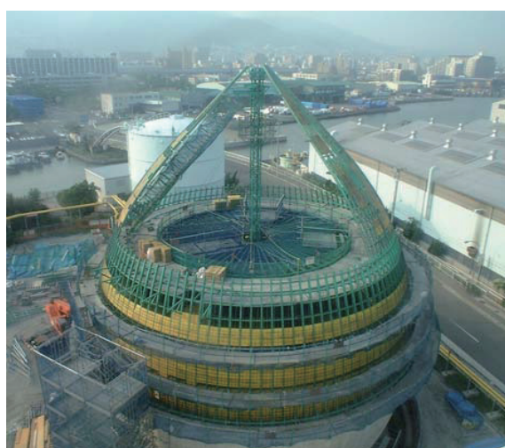
写真-3 側壁部(赤道上)
