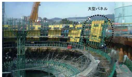
写真-1 大型パネル工法
