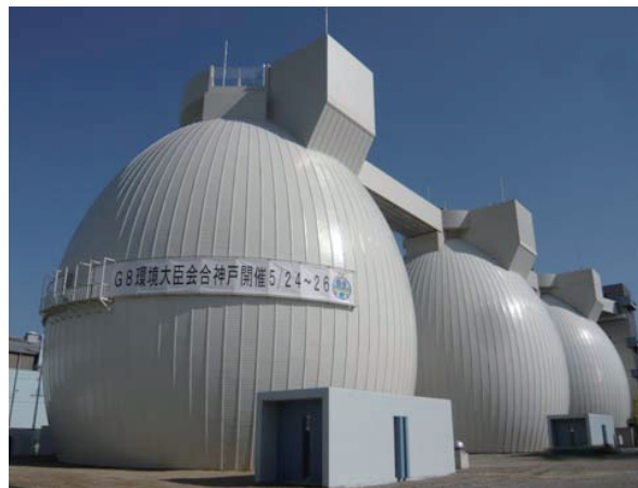
写真-4 完成した卵形消化タンク
