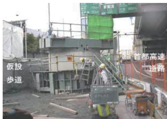
写真-2 近接状況写真
