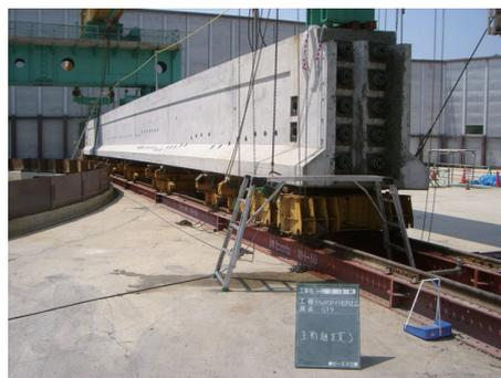
写真-3 主桁セグメント組立完了
