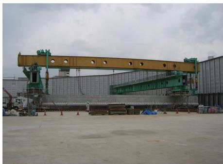
写真-4 架設状況 (桁横移動中)
