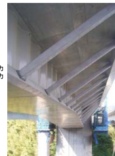
写真-5 施工状況写真
