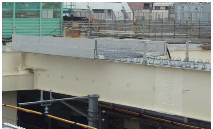
写真-1 HPCa 版設置状況写真
