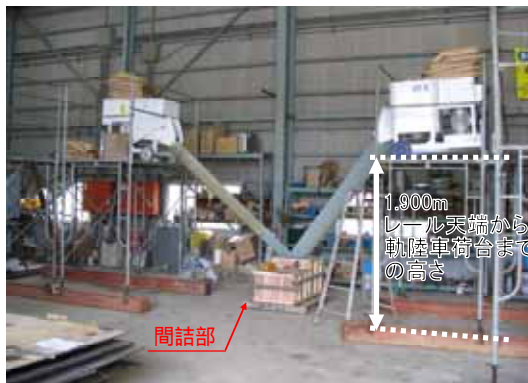
写真-3 グラウトミキサー設置状況
