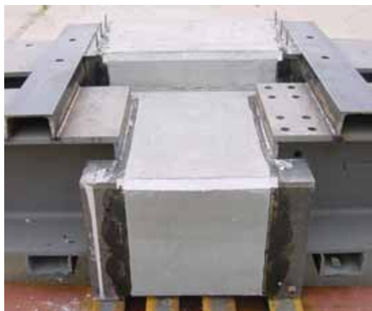
写真-4 脱枠後表面仕上がり状況
