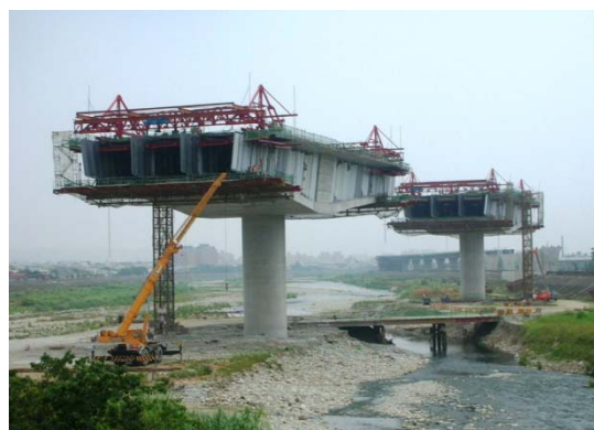
写真-1 施工状況 (C707 工区 UNIT3)
