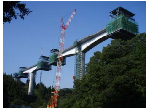
写真—1 張出し架設時全景
