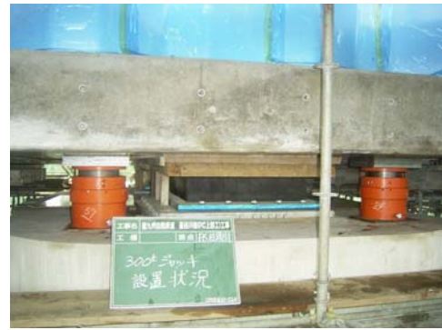
写真-2 油圧ジャッキ設置状況
