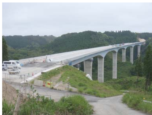
写真-3 全景写真
