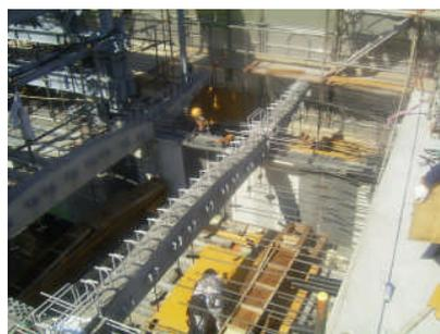
写真-2 PCa リブ設置状況
