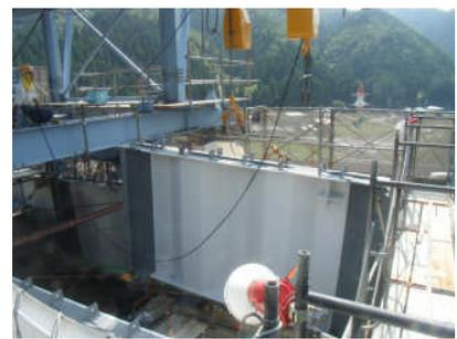
写真-3 波形鋼板設置状況
