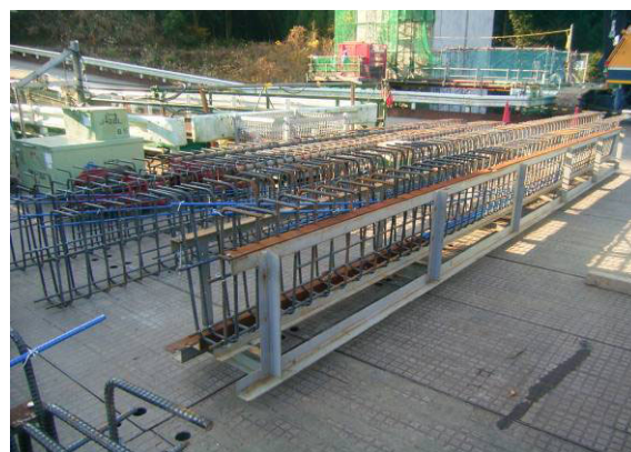
写真-1 水平リブのプレファブ鉄筋組立状況
