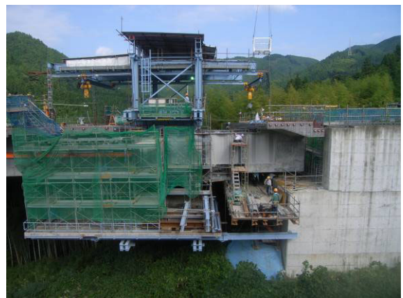
写真-5 側径間部の施工
