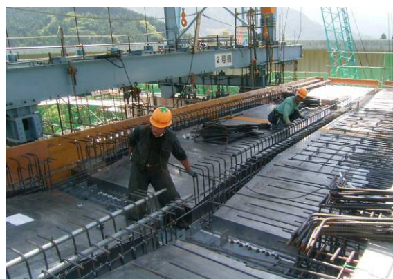
写真-2 型枠内への鉄筋配置
