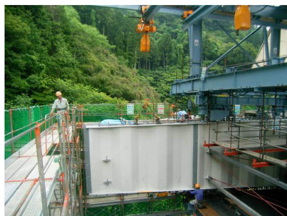
写真-3 波形鋼板架設状況
