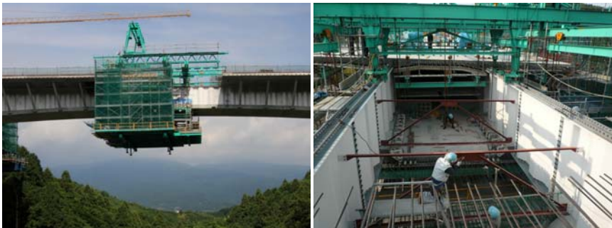
写真-4 中央閉合部施工状況
