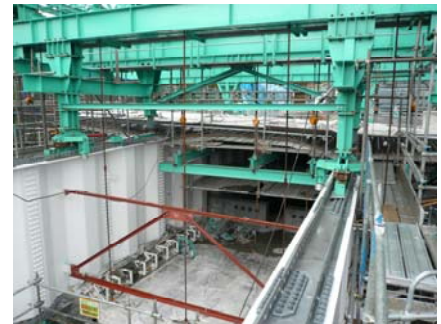
写真-3 張出し部施工状況
