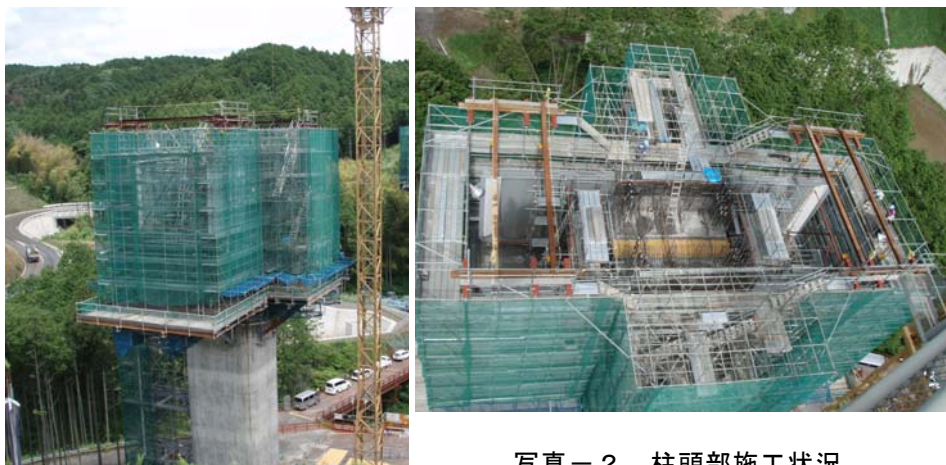
写真-2 柱頭部施工状況
