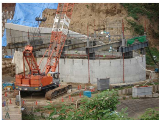
写真-1 基礎工施工状況
