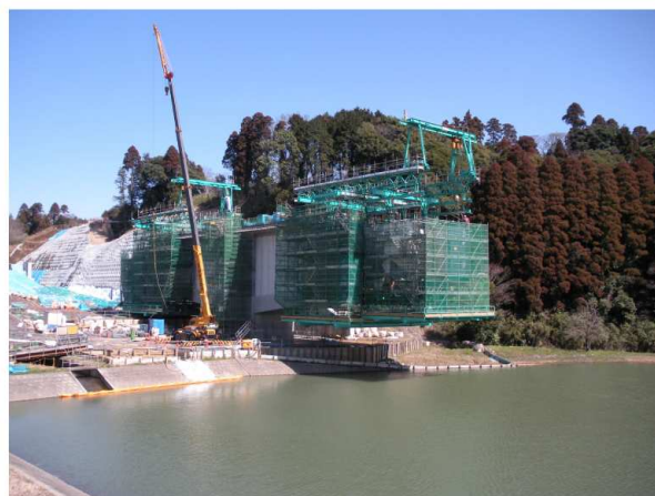
写-2 上部工施工状況 H21.4.28
