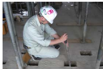
写真-1 トルクレンチによる手締め状況
