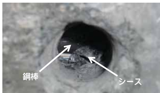
図 - 11 削孔状況
