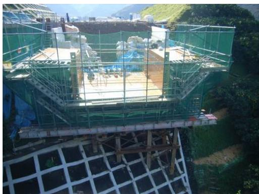
写真-3 側径間支保工設置状況
