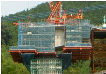
写真-2 移動作業車設置状況
