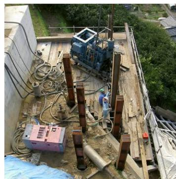
写真-4 基礎杭施工状況
