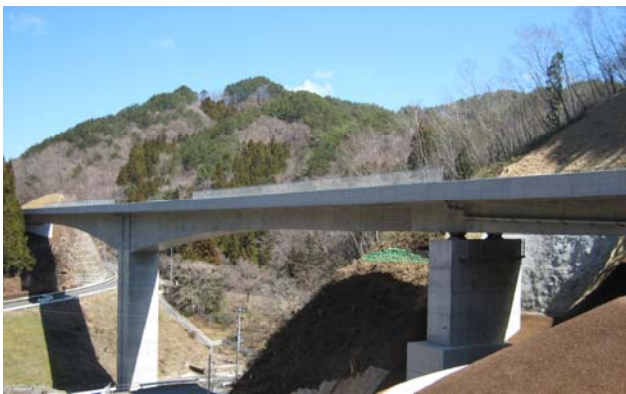
写真-1 両石高架橋 全景
