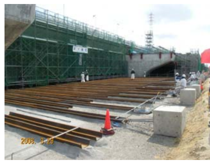
写真-2 枠組支保工の横移動
