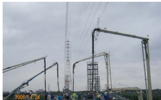
写真-12 コンクリート打設作業での実施状況
