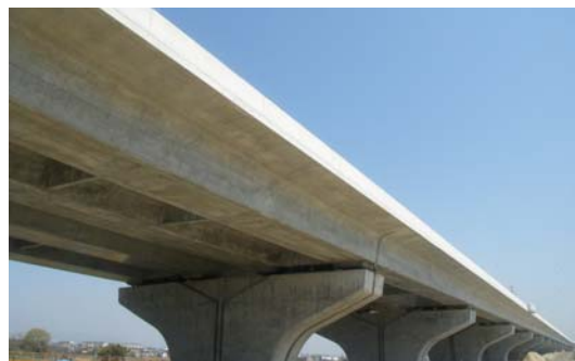
写真-19 工事完成
