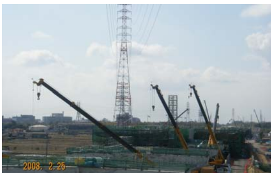
写真-11 クレーン揚重作業での実施状況
