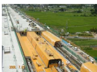
写真-9 システム型枠の移動状況
