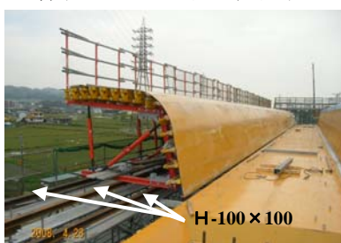
写真-7 システム型枠の移動
