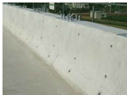
写真-18 壁高欄仕上がり面
