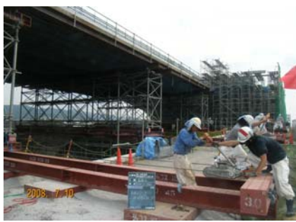
写真-4 支柱桁式支保工の横移動
