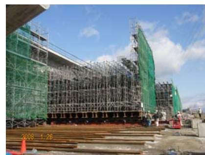
写真-5 水路部桁区間の横移動
