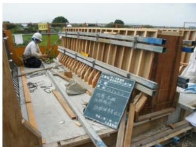
写真-13 試験施工：型枠組立
