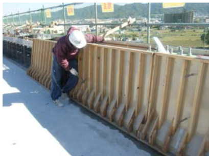
写真-16 紙型枠の組立
