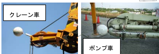
写真-10 リフレクターの取り付け状況
