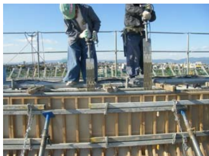
写真-17 コンクリート打設：仕上げ板バンプ
