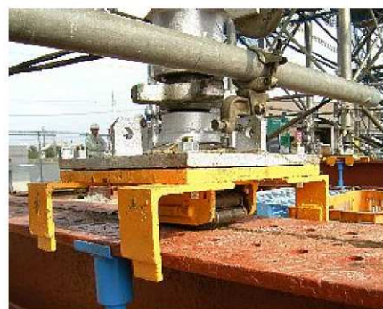
写真-2 支保工移動用ローラー
