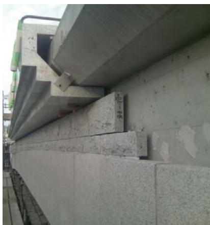
図-9 石張り施工状況
