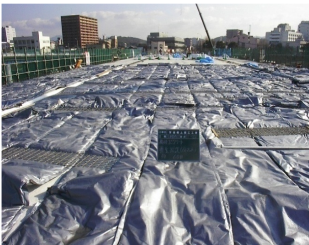
図-4 保温性・保水性の高い養生マットの使用状況
