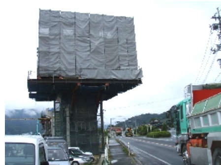
写真-2 ブラケット式支保工
