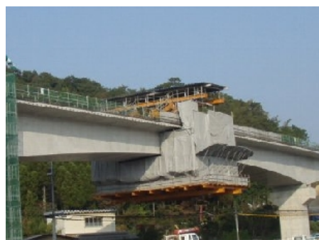
写真-4 中央閉合部の施工
