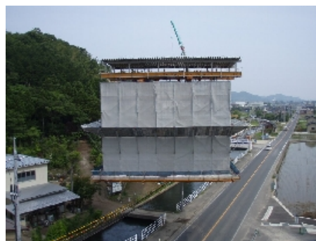
写真-3 移動台車全面防護状況
