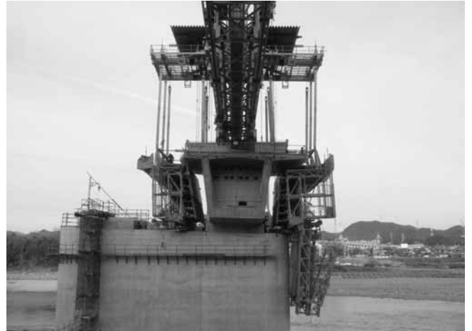
写真 - 5 橋脚通過時型枠閉閉
