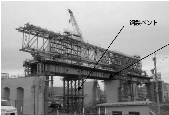
写真 - 2 送り桁 組立
