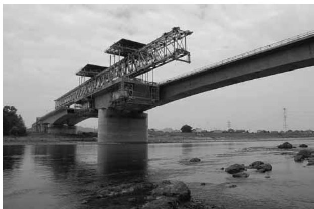
写真 - 6 施工時の長良川橋
