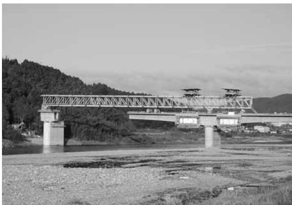
写真 - 3 送り桁 径間移動
