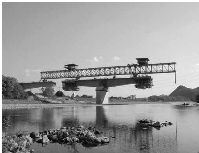
写真 - 1 P & Z工法 施工状況
