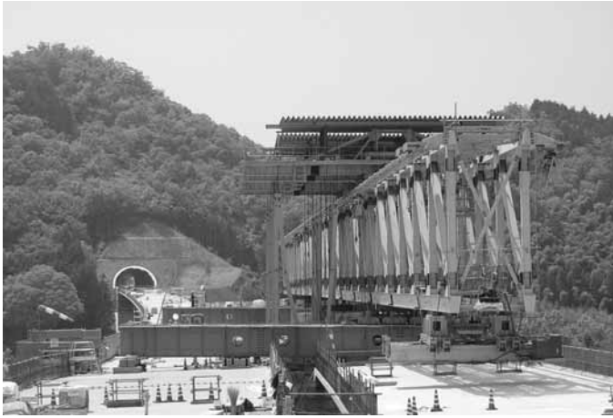
写真 - 4 送り桁横取り (左から右へ)
