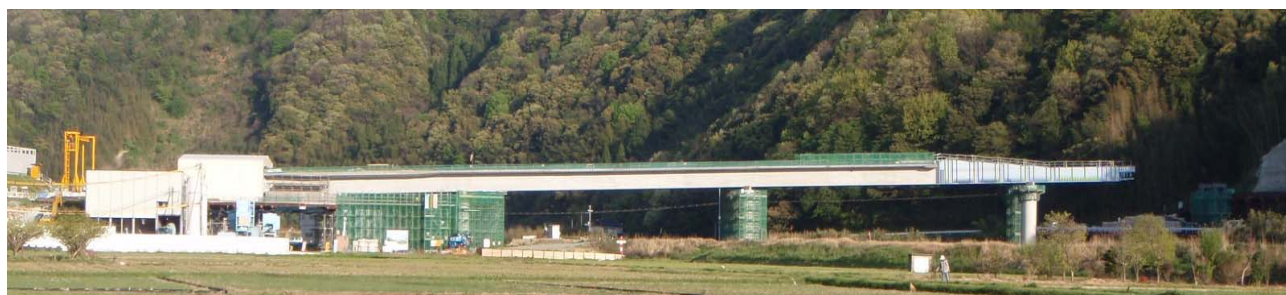
写真-4 押出し架設状況 (10BL)
