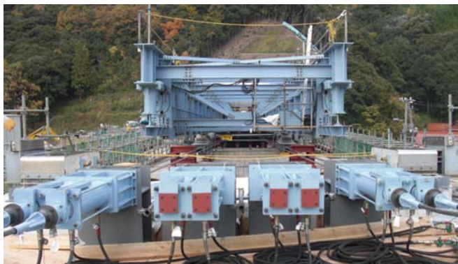
写真-1 押出し用センターホールジャッキ
