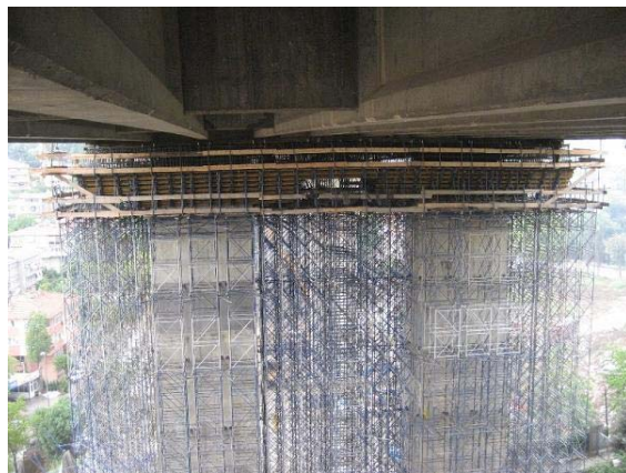
写真-3 新設 PC 横梁の型枠設置状況
