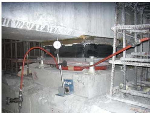
写真-4 沓とフラットジャッキの設置状況
