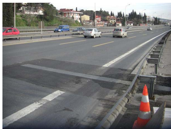
写真-5 伸縮装置(第一施工区間完了後)
