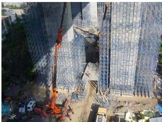
写真-2 新設 PC 横梁の足場架設状況
