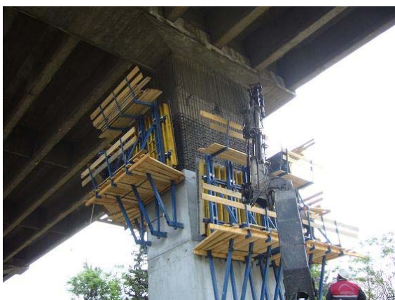
写真-1 型枠のリフトアップ
