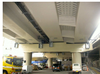
写真-13 箱桁部の完成全景
