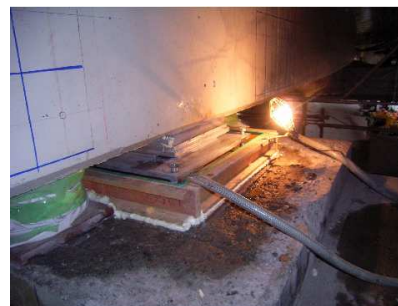
写真-11 モルタル施工
