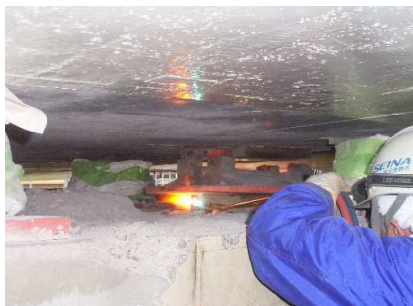
写真-9 既設支承撤去
