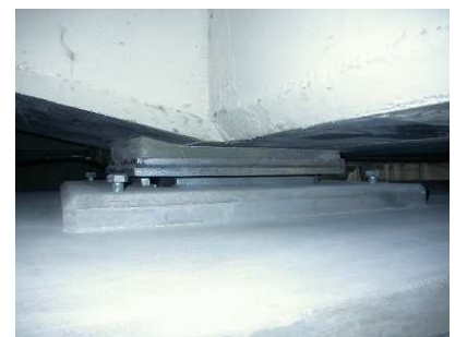
写真-8 新設支承
