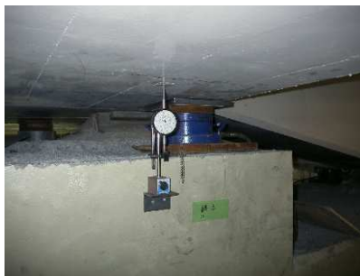
写真-10 上部工仮受け
