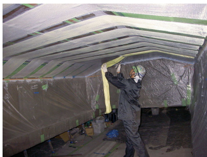
写真-12 アラミド繊維シート補強
