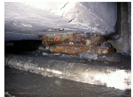
写真-7 既設支承
