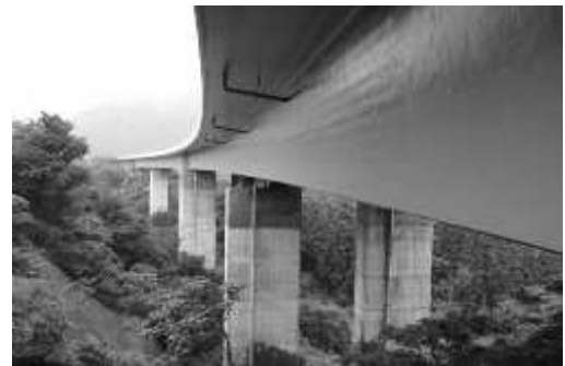
写真-1 上輪新田橋PC箱桁部全景
