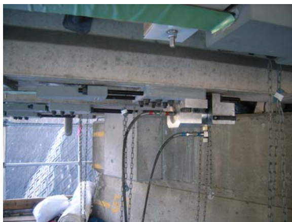
写真-2 爪付きジャッキ設置状況
