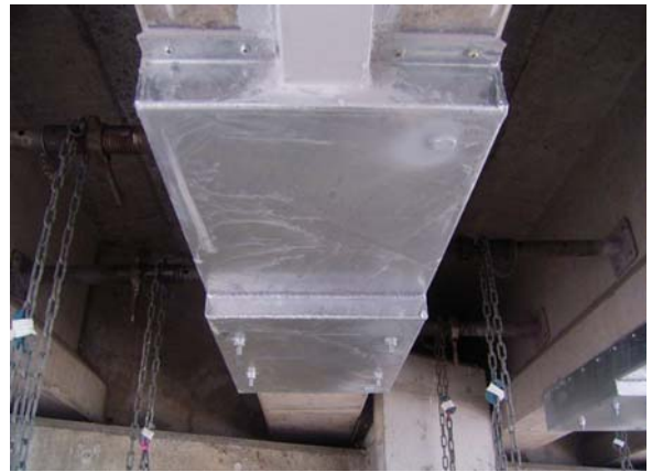
写真-3 定着体保護カバー設置状況
