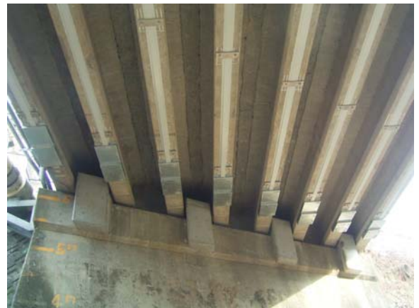
写真-4 施工完了後全景 (AR側)
