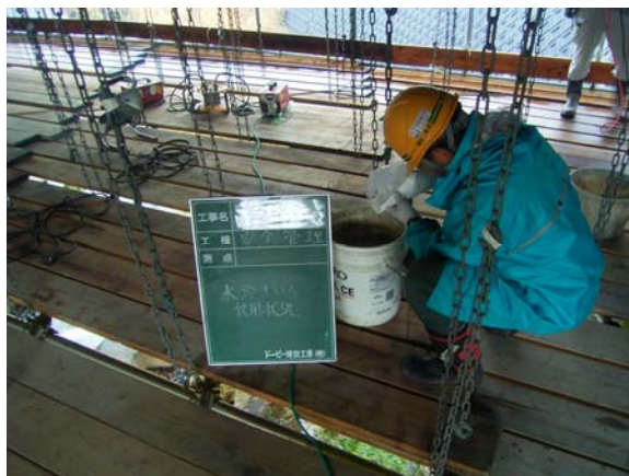
写真-1 凝集沈降剤投入状況
