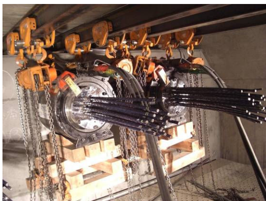
写真-8 ジャッキセット状況
