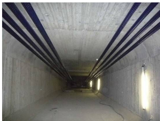
写真-9 外ケーブル配置完了
