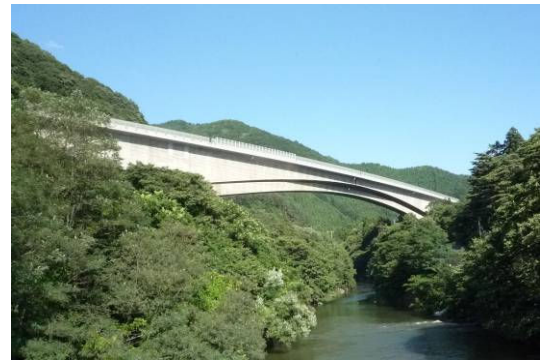
写真-1 八幡平橋全景
