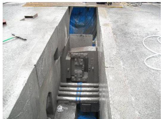
写真-5 上床版撤去完了
