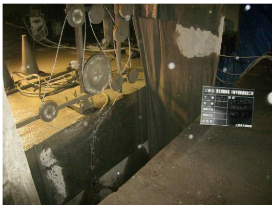
写真-4 ワイヤーソー切断状況
