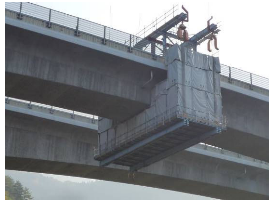
写真-3 吊り足場設置状況
