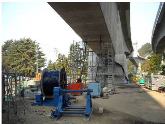
写真-6 外ケーブル挿入状況
