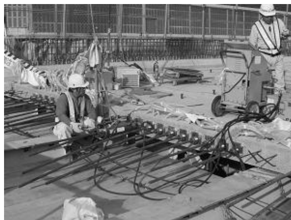
写真-3 橋軸方向プレストレス導入状況
