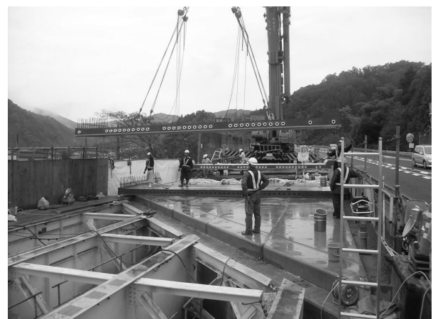
写真-5 延長床版の設置状況
