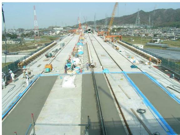
写真-9 床版コンクリート打設完了
