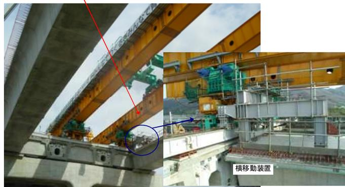
写真-6 横移動、PCケーブル挿入・緊張
