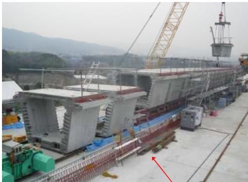
写真-3 既設桁上でのセグメント接合
