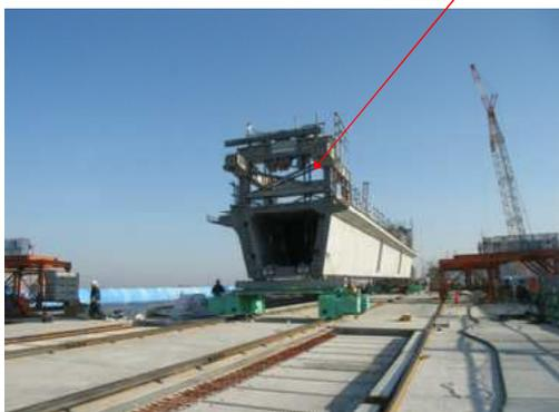
写真-4 主桁の橋面運搬
